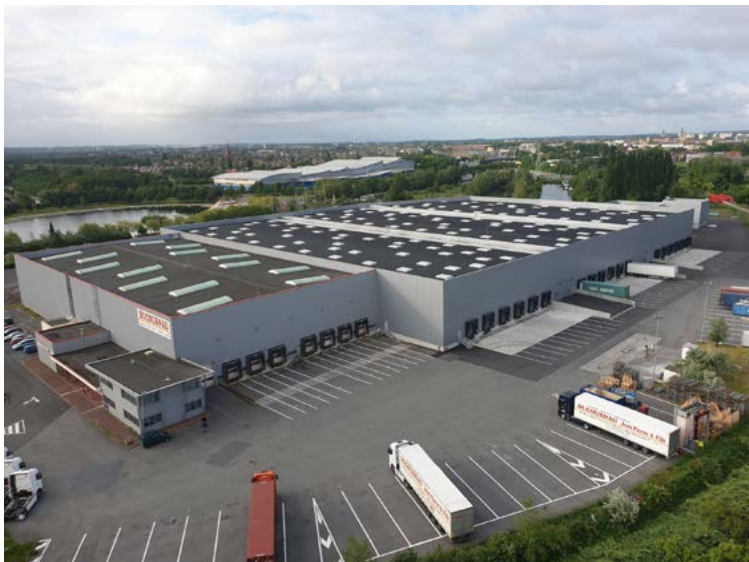
Transports Ducournau, dépôt de Douai (59)
